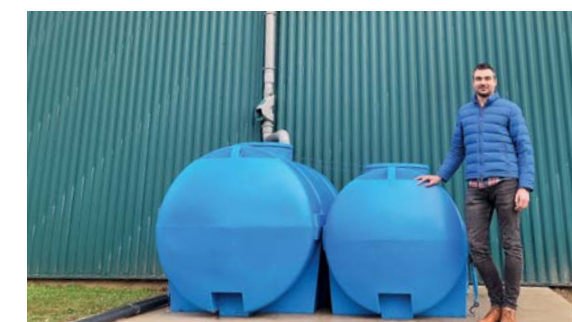
Fabien Leroux, directeur de la plateforme de distribution du courrier de Fécamp, présente les cuves de récupération des eaux pluviales d'une capacité de stockage totale de 4 600 litres.
