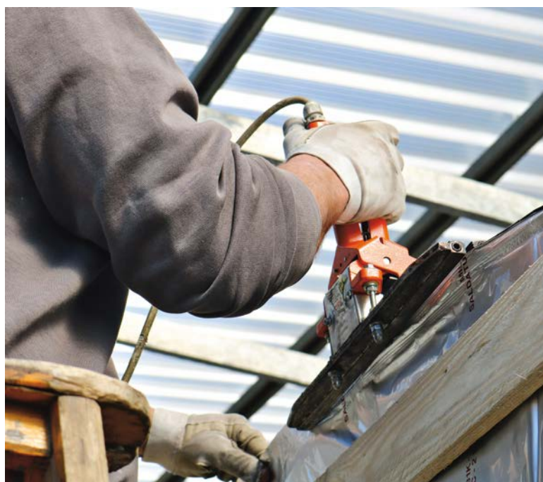
Un artisan intervient pour réaliser les travaux.
