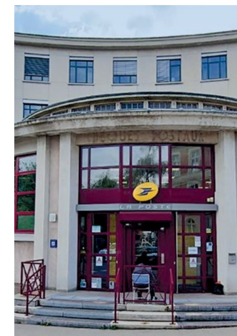
Le centre financier de Strasbourg est engagé dans un processus d'amélioration continue de la performance énergétique du bâtiment.
