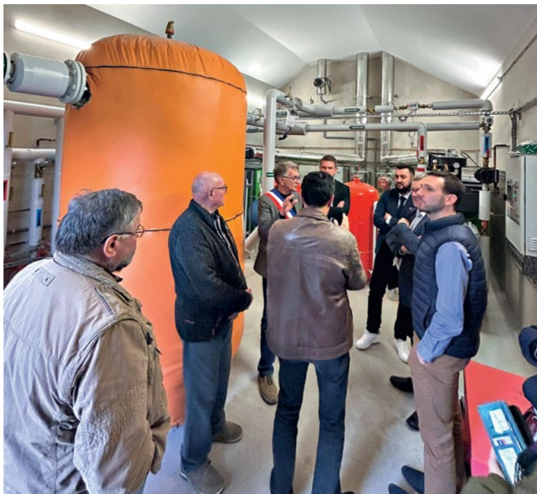
Inauguration à Saint-Usuge de la nouvelle chaufferie, le 11 avril 2025.
