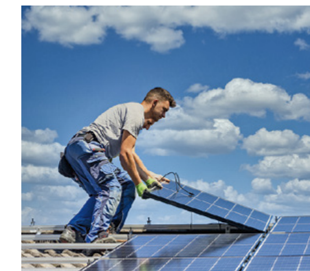
POSE DE PANNEAUX PHOTOVOLTAÏQUES / Loos-en-Gohelle accompagné financièrement par La Banque Postale.
