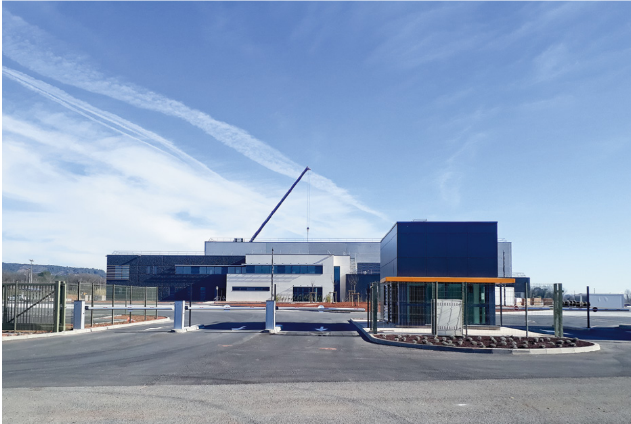
LE CHANTIER DE LA FUTURE PLATE-FORME COLISSIMO CÔTE D'AZUR, AU PARC LOGISTIQUE DES BRÉGUIÈRES.
